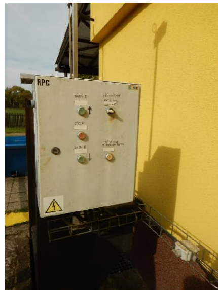
Ovládací skříň stavidlové tabule a stíracího stroje
